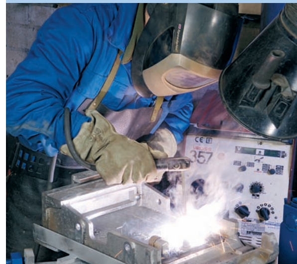
■ Konstruktionsschweißung mit Lost Foam-Bauteilen
